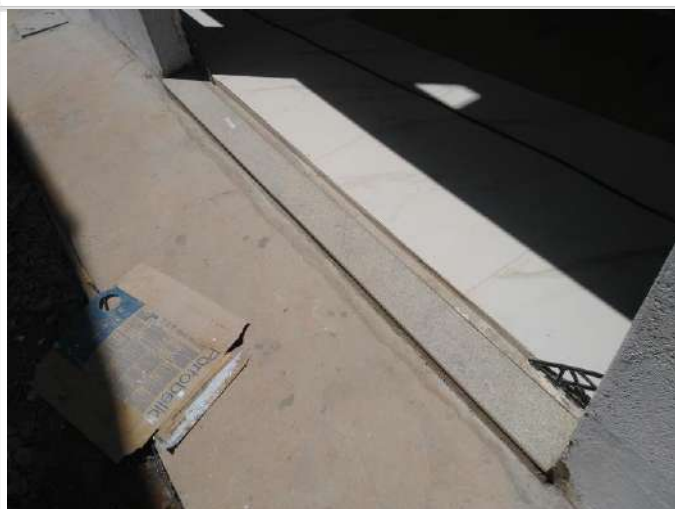
Foto 3 – Instalação de Soleiras
