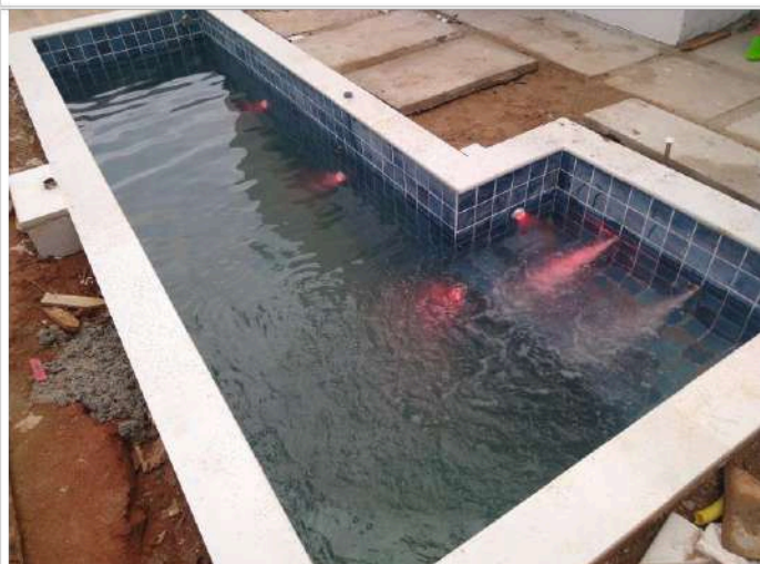
Foto 12 – Instalação das luzes e hidromassagem da piscina
