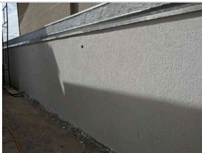
Foto 11 – Aplicação de grafiato no muro de divisa
