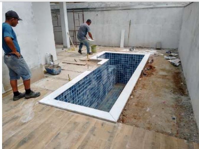
Foto v – Instalação da borda da piscina
